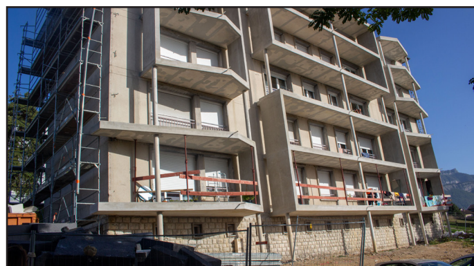
Travaux en cours
