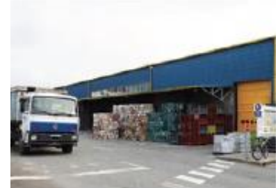
Centre de tri Savoie-Déchets
