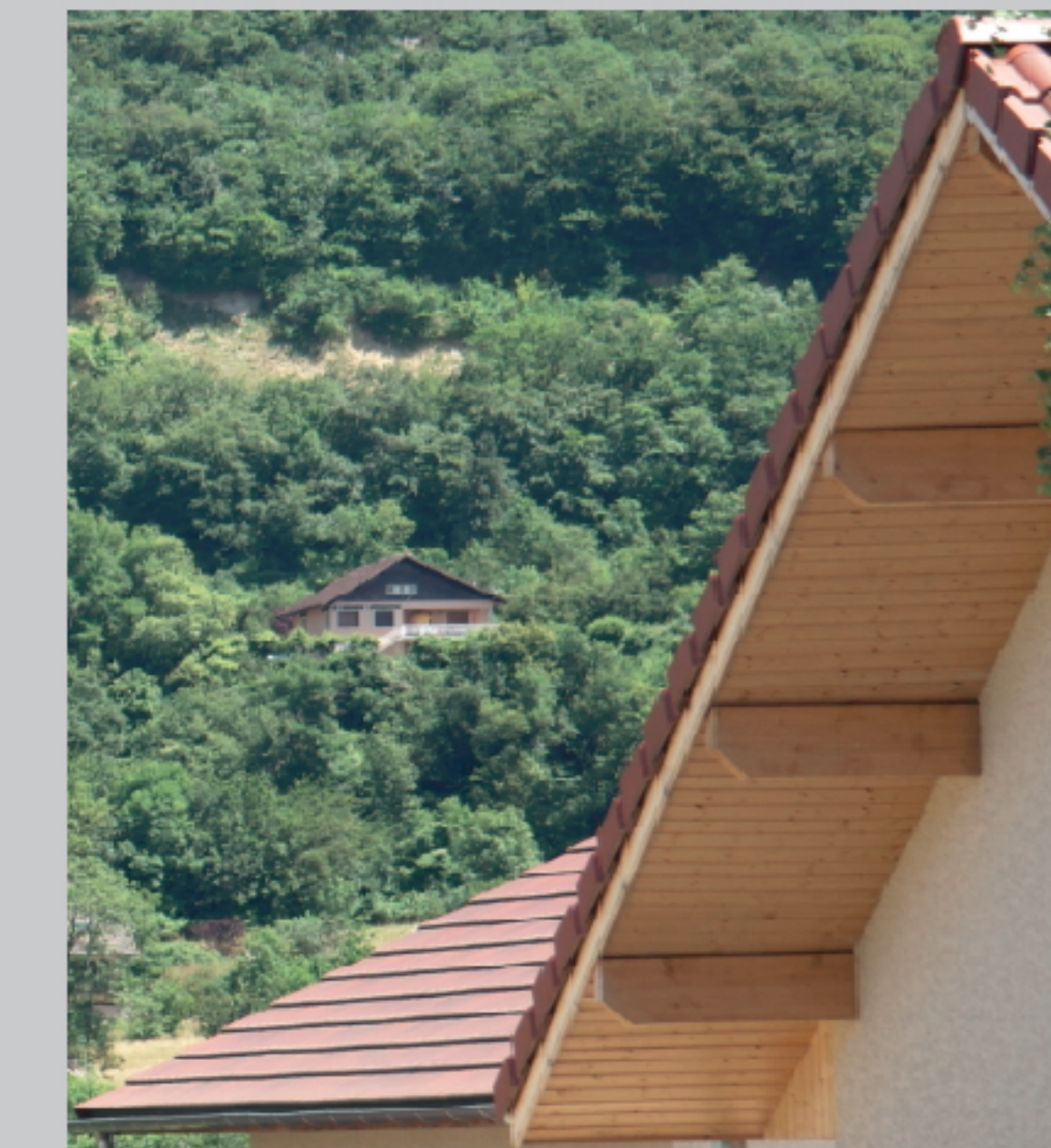
Le débord de toiture est la norme
