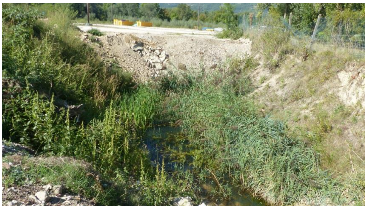
Mare en cours de comblement des Étangs au Sud de la Fabrique Epode, le 05 septembre 2018
